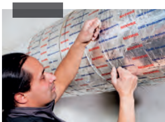
Minimaal 6 wikkelingen/m 2 met een staaldraad van minimaal 0,5 mm.
